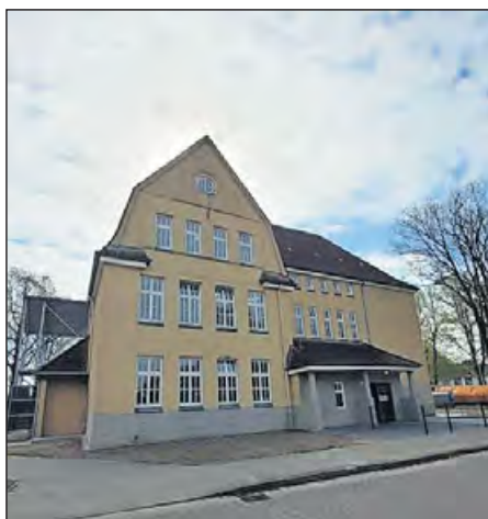
Die alte Bibliothek in Otterndorf wurde umgebaut: Zurzeit ist dort der Hort untergebracht, später werden die Räumlichkeiten für den Schulbetrieb genutzt.
